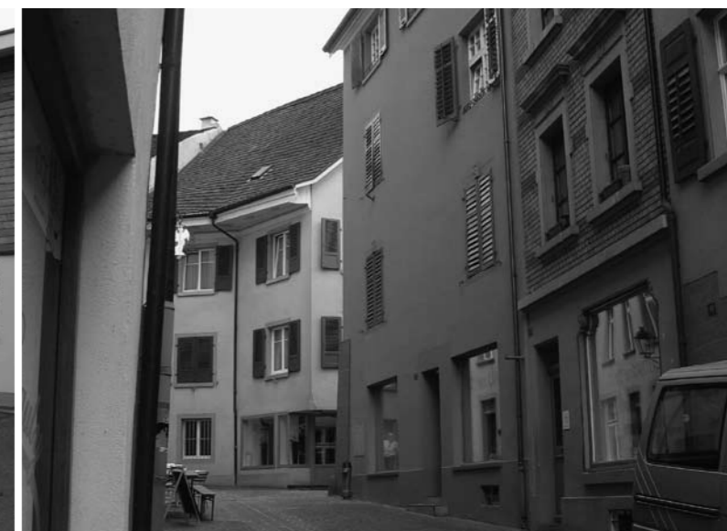
links: Forstwerkhof nach Sanierung. rechts: Liegenschaft Kirchgasse 2 nach Sanierung.
