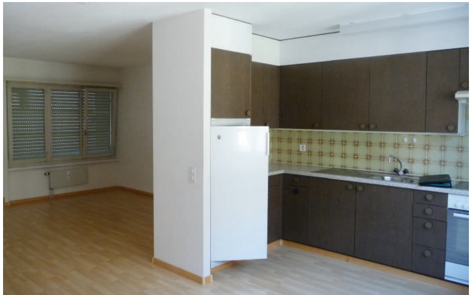
Veraltete Badezimmer und Küchen vor der Sanierung
