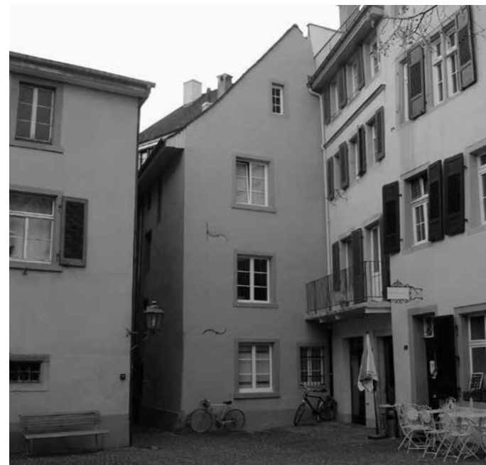
Kirchgässli 11 vor und nach der Sanierung
