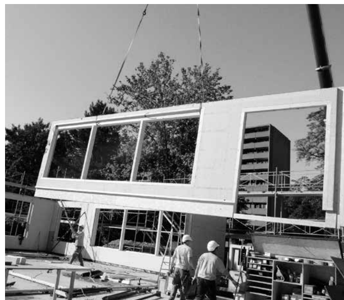
Kindergarten «Im Holder» im Bau
