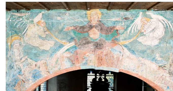
Die Malereien sind in unterschiedlich stabilem Zustand.
