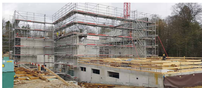
Frühjahr 2020: Die im Bau befindliche Heizzentrale nimmt Gestalt an.
