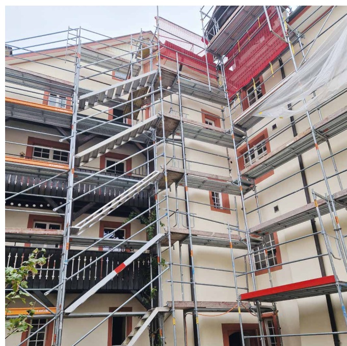
und während der Sanierungsarbeiten
