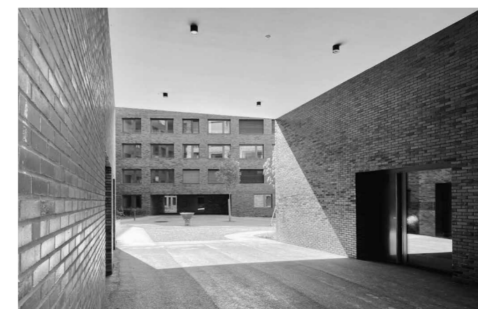
Blick in einen der Innenhöfe kurz nach der Fertigstellung
