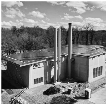
Neue Heizzentrale des Wärmeverbunds Rüchi
