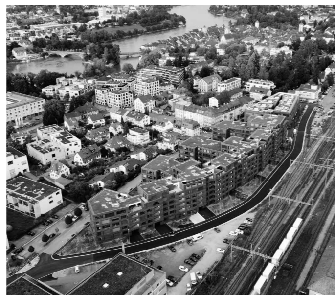
Die neue Fassbindstrasse aus der Vogelperspektive (Quelle: F. Preisig AG, Aarau)
