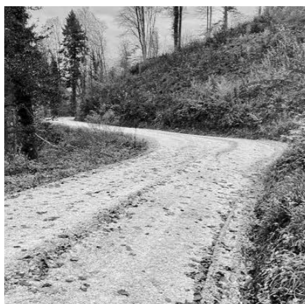
Die Waldstrasse nach Abschluss der Arbeiten
