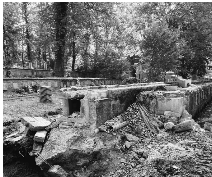
Rückbau der freistehenden Urnenmauern
