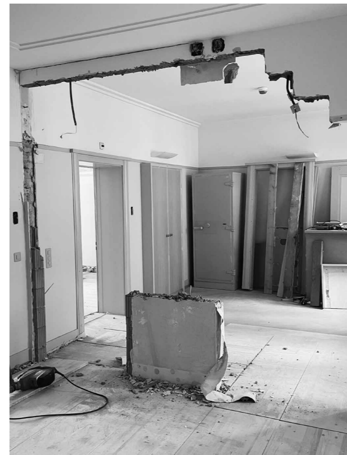
Einblick in die Vorbereitungsarbeiten
