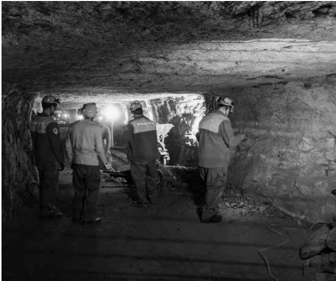
Einsatz der Beleuchtungsgeräte im Bergwerkstollen Herznach
