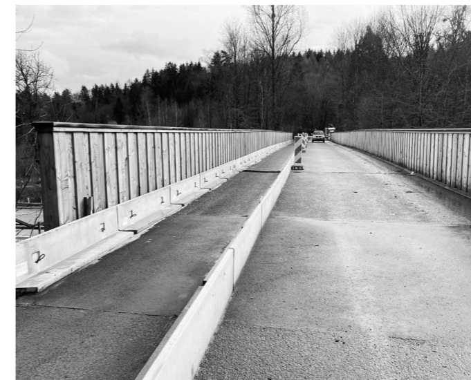
Brücke im Frühjahr 2021 mit beidseitiger Blendschutz-Holzschalung, vor Einbau des Bodensubstrats
