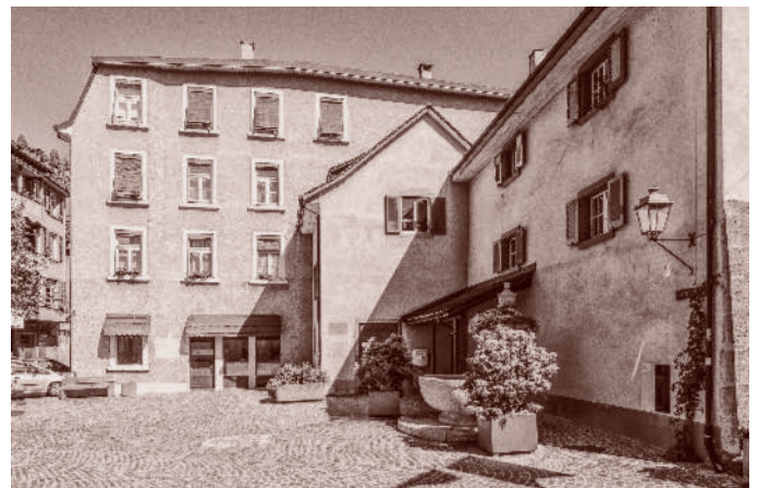
Unter dem Vordach der städtischen Liegenschaft am Zähringerplatz (rechts im Bild) wird der neue Bancomat eingebaut
