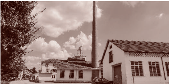
Der Hochkamin des ehemaligen Furnierwerks musste zu Gunsten der Überbauung abgerissen werden
