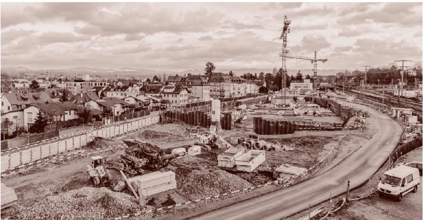
Die Baubewilligung für die Transformation des ehemaligen Furnierwerk-Areals zum Wohnbauprojekt der Firma Densa wird zu 155 neuen Mietwohnungen und zu rund 3'000 m 2 zusätzlichen Gewerbeflächen führen
