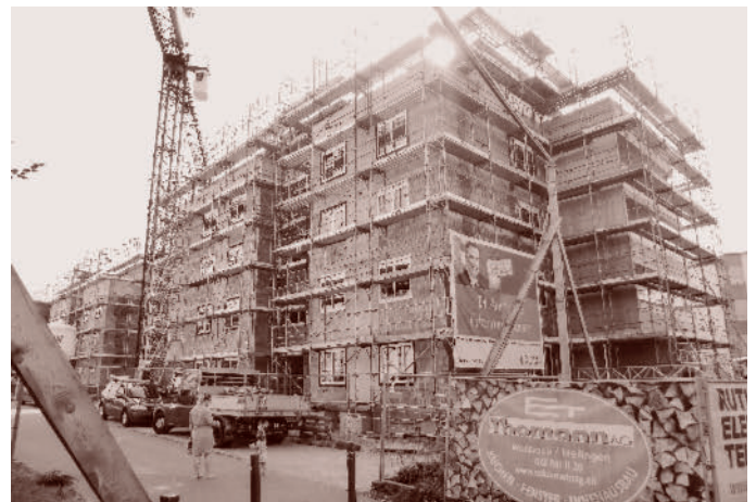
Die durch das Stadtbauamt zu überwachende Grossbaustelle «Überbauung Töpferweg»
