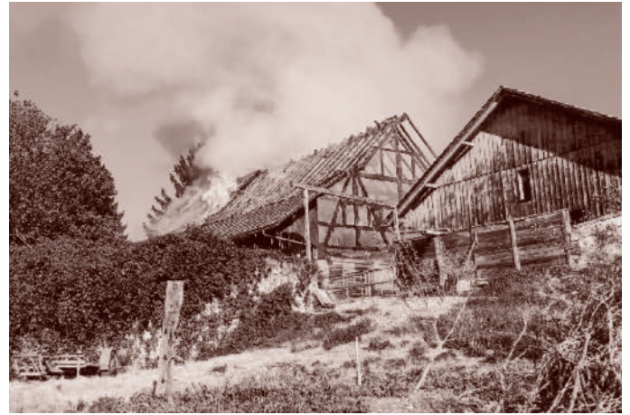
Löscharbeiten beim Brand eines Wohnhauses mit Stall in Zeiningen
